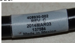
Figur 1 Forkert monteret strømkabel, falder inden for datointervallet
